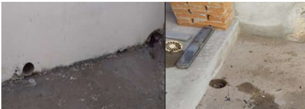
Figura 40. Ralos de tanques interligados em galeria pluvial, rumo lago Jaboti.
