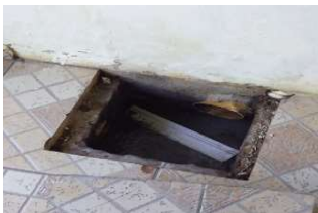
Figura 41. Caixa de gordura irregular (à esquerda) e formato recomendado pela SANEPAR (à direita).
