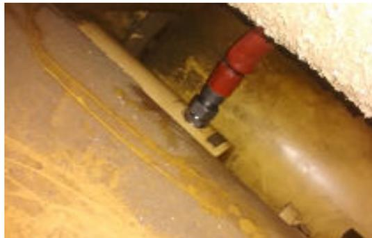
**Figura 14 – Localização aproximada do niple de redução no cilindro**
