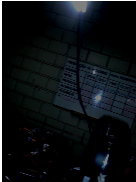
Figura 27 - Cabo exposto – setor acabamento I Fonte: Autoria Própria
