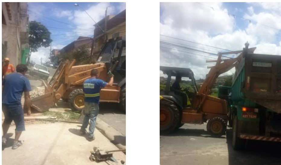
Figura 13 - Retroescavadeira pegando entulho e depositando no caminhão
