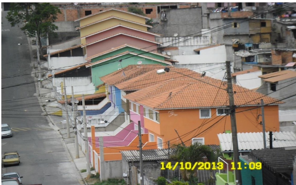
Foto 02 – Conjunto de residência no Bairro Maria Judith – Itapevi – São Paulo construído nos padrões exigidos pelos órgãos de planejamento urbano.
