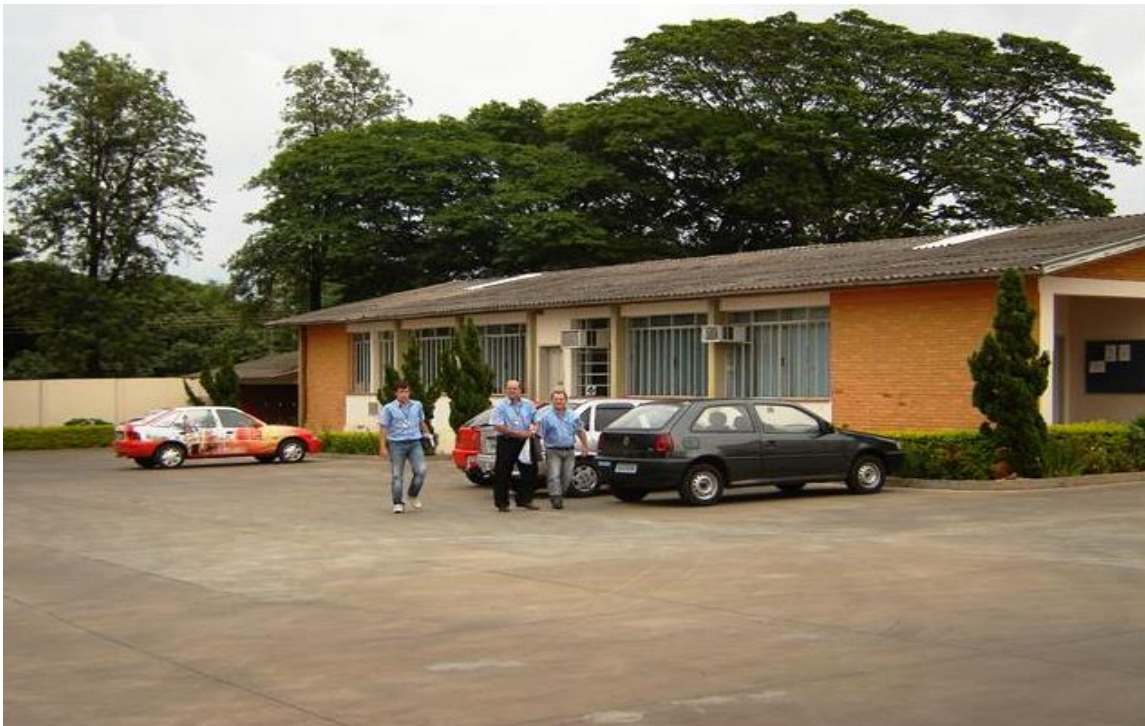
Prédio Administrativo da Indústria e Comércio de Refrigerantes Garoto.
