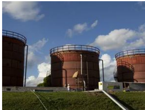
Figura 14 – Estação Cassarongongo, Tratamento dos Efluentes dos Poços de Petróleo. Fonte: Petroreconcavo, 2011
