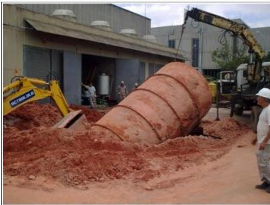
**Figura 15 – Remoção de tanques de armazenamento subterrâneos (TAS) em Barueri, São Paulo.**
