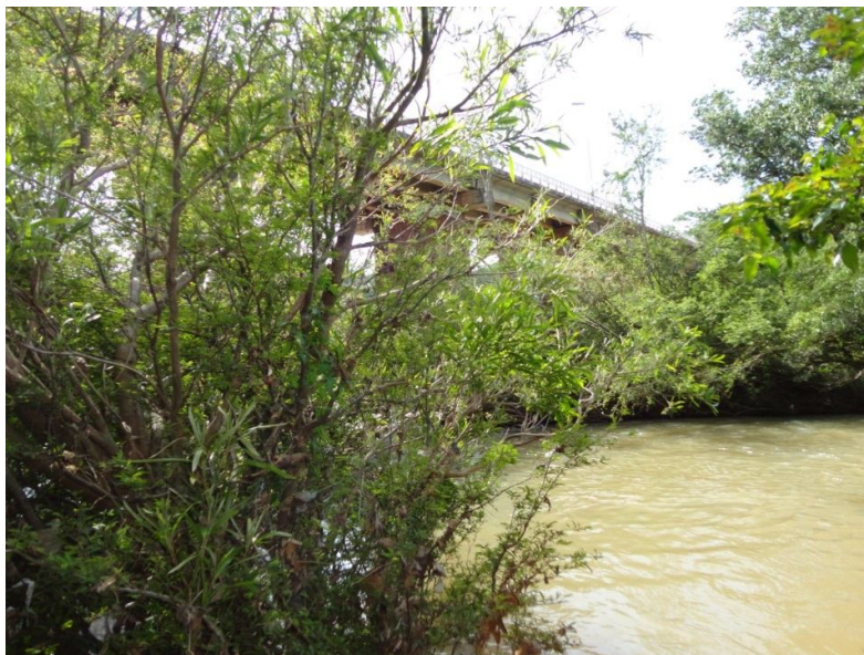
Figura 17: Ponto 10, Localizado a Poucos Metros da Ponte Irineu Bornhausen.
