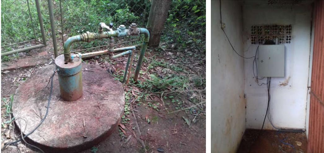
**Figura 4 e 5 – Barrilete e quadro de comando de energia do poço de abastecimento.**
