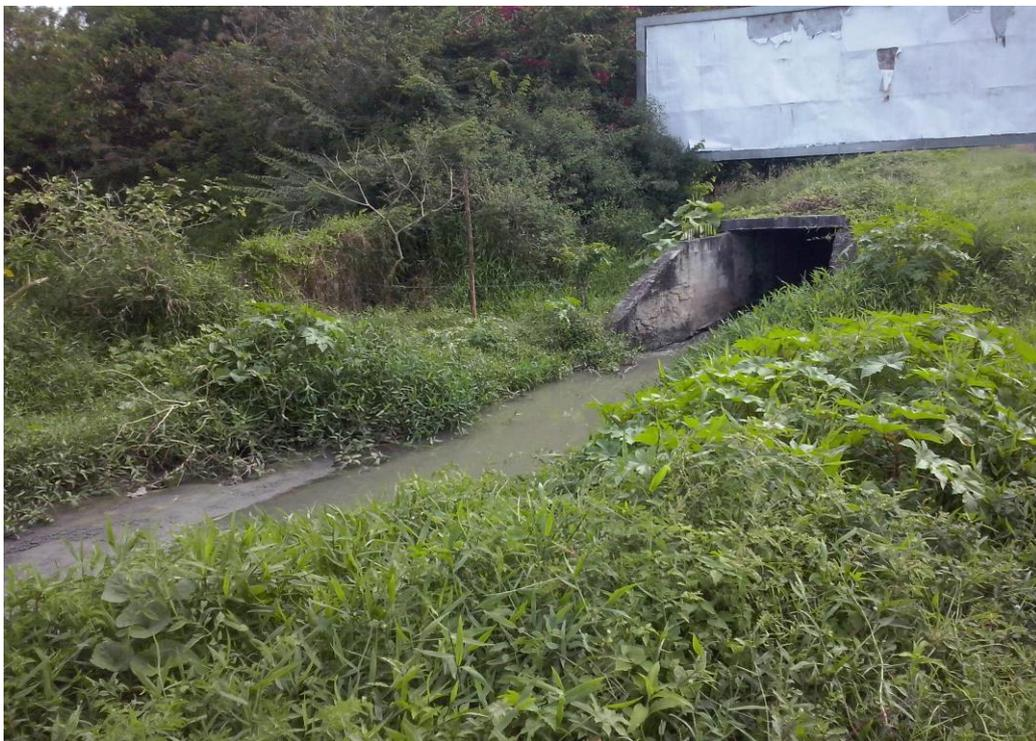
**Figura 36: Saída de Canal de Drenagem de Águas Pluviais Contaminadas com Esgotos Oriundos de Ligações Clandestinas.**
