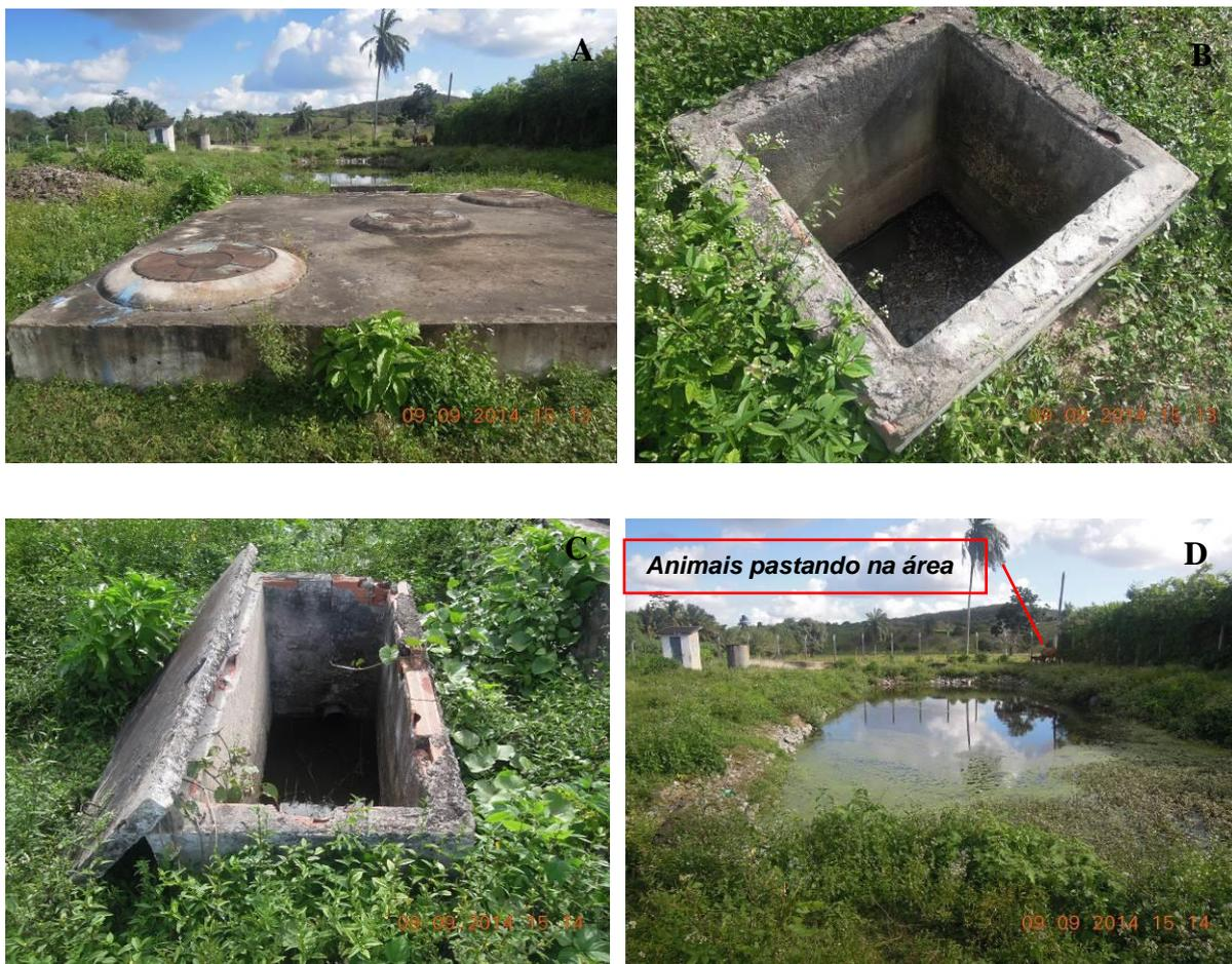
Figura 19: ETE 09: A) Tanque Séptico e *Wetland*; B) Caixa de Inspeção Aberta e Cheia de Dejetos; C) Caixa de Inspeção Aberta e Mal Conservada; D) Lagoa do Sistema *Wetland* Coberta pela Vegetação.
