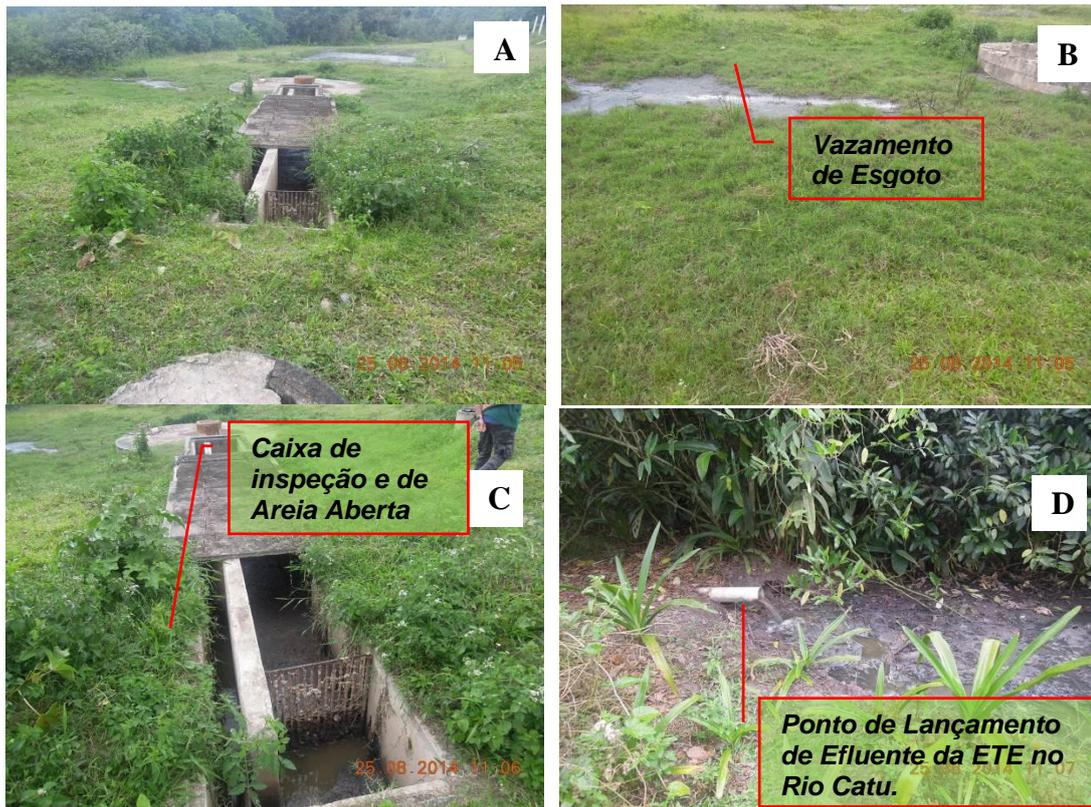
Figura 28: ETE 13: A) Vista Frontal da Estrutura da ETE; B) Vazamento de Esgoto; C) Caixa de Inspeção e Areia Aberta; D) Ponto de Lançamento de Efluente. Fonte: Elaborada pelo Autor, 2014.
