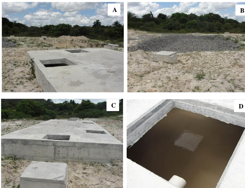
**Figura 32: ETE 14: A) Vista Geral da Estrutura da ETE; B) *Wetland* com Implantação Incompleta; C) Direcionamento do Sistema de Tratamento; D) Tanque Séptico com Tampa Aberta.**
