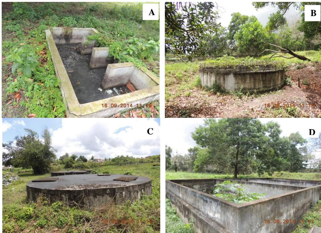
**Figura 23: ETE 11: A) Caixa de Distribuição Inacabada; B) DAFA Inacabado Acumulando Água de Chuva; C) DAFAs da ETE 11 Jardim Petrolar; D) Leito de Secagem Abandonado Estrutura Inacabada.**
