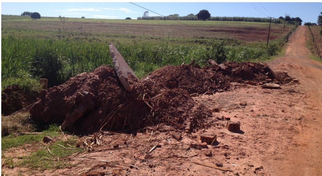
Figura 12 – Resíduos de Construção dentro do rio Fonte: Autor, 2014.
