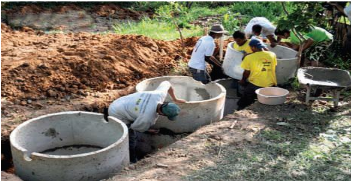
Figura 08: Montagem dos Tanques Sépticos 1. Fonte: Aleudo (2010).
