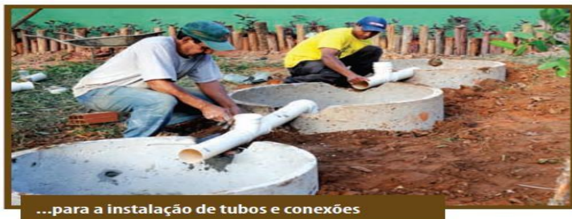
Figura 09: Montagem dos Tanques Sépticos 2. Fonte: Aleudo (2010).
