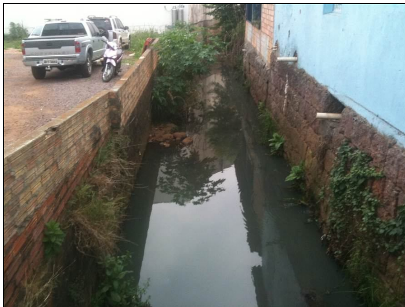
Figura 5 - Ponto de lançamento de esgoto doméstico in natura na área central. Fonte: Prefeitura Municipal de Concórdia, 2012.
