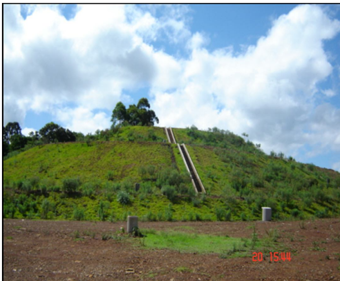
Figura 8 - Área recuperada do antigo lixão Linha Vitória. Fonte: Prefeitura Municipal de Concórdia, 2013.
