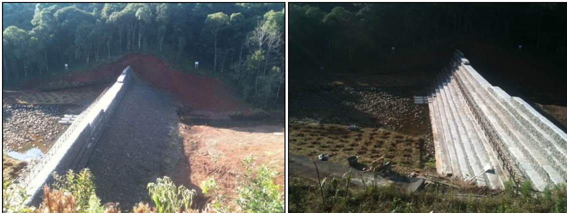
Figura 12 - Barragem de Contenção de cheias – Obra executada para Macrodrenagem.
