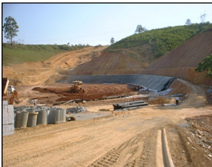
Figura 9 - Obras de implantação do Aterro Sanitário. Fonte: Prefeitura Municipal de Concórdia, 2013.
