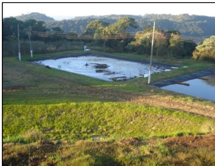
Figura 11 - Sistema de tratamento e de drenagem de percolados. Fonte: Prefeitura Municipal de Concórdia, 2013.
