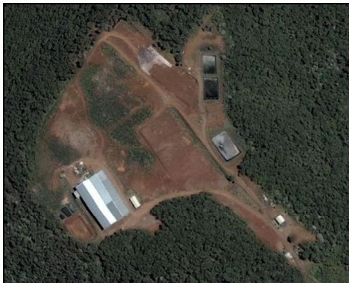
Figura 10 - Vista aérea do Aterro Sanitário após a conclusão das obras. Fonte: Prefeitura Municipal de Concórdia, 2013.
