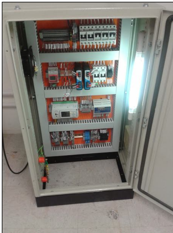
Figura 9. Painel de monitoramento para unidades produtivas de biogás
