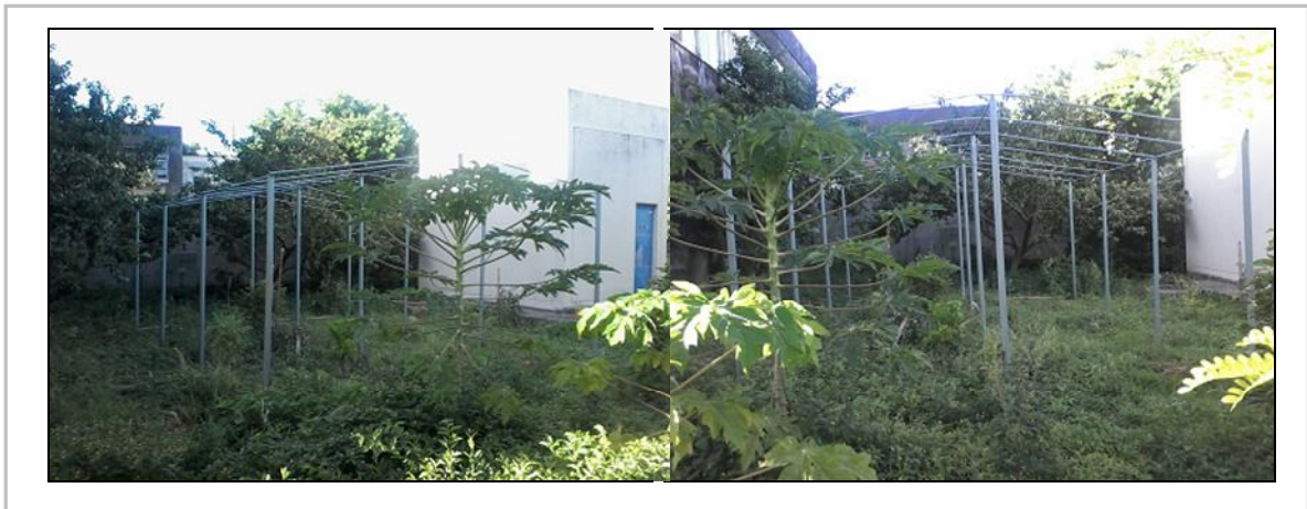
Figura 4. Estrutura para construção de estufa de hidroponia aguardando finalização da obra. Fonte: Autor.
