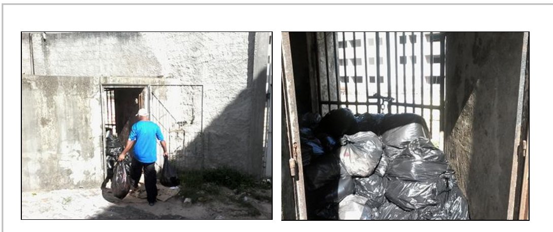
Figura 17. Depósito para disposição de lixo comum. Fonte: Autor.
