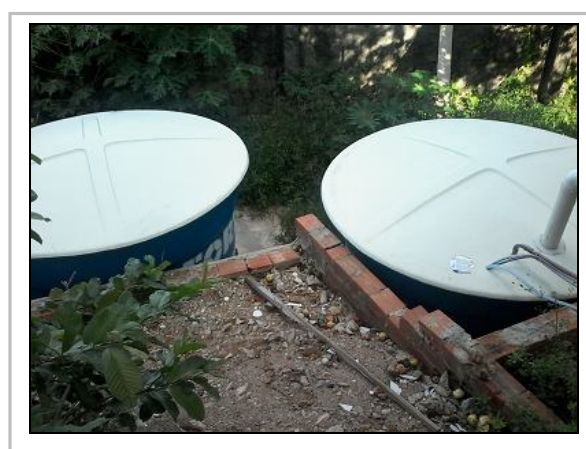
Figura 9. Reservatórios. Fonte: Autor.
