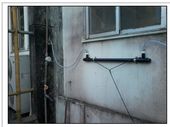
Figura 11. Lâmpada de esterilização UV. Fonte: Autor.
