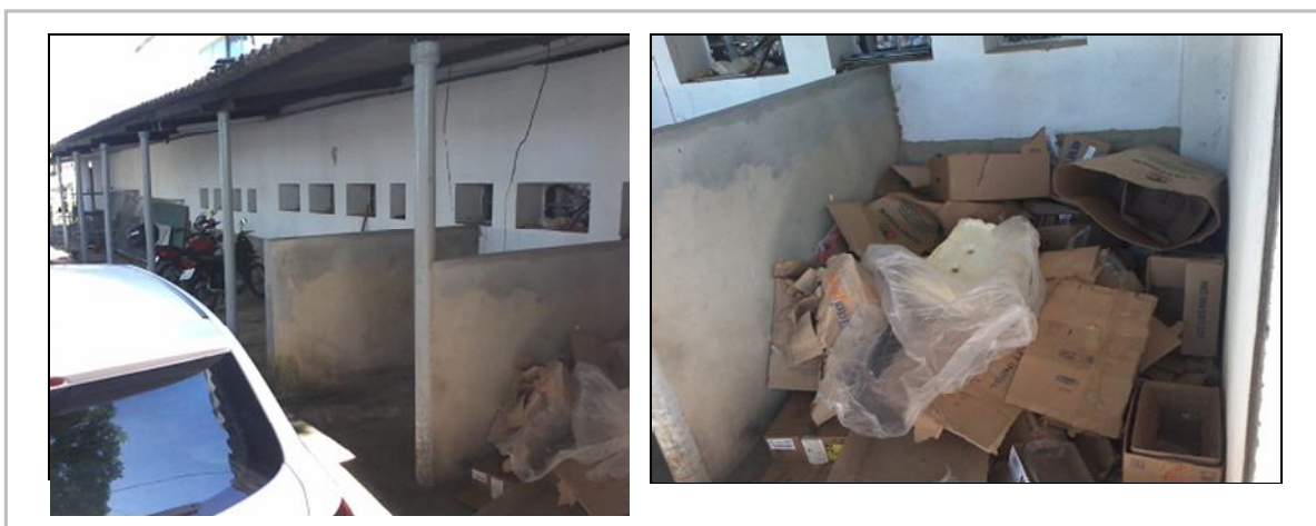
Figura 15. Área de armazenamento de resíduo próximo ao estacionamento. Fonte: Autor.
