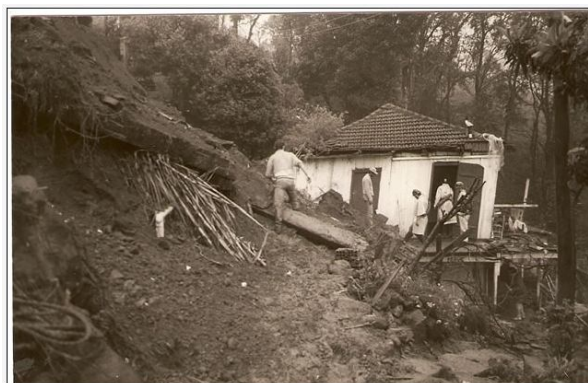
Figura 08: Casa Atingida por Deslizamento, 1979. Fonte: Queimados Vivo (2014).
