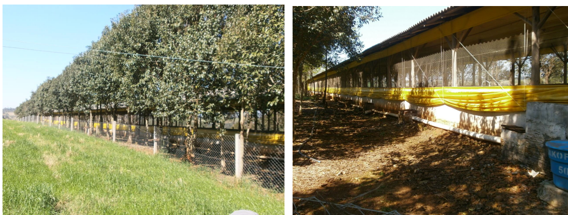
Figura 7 – Características das Instalações nas Unidades de Produção Mais Recentes Fonte: SOUZA (2014).
