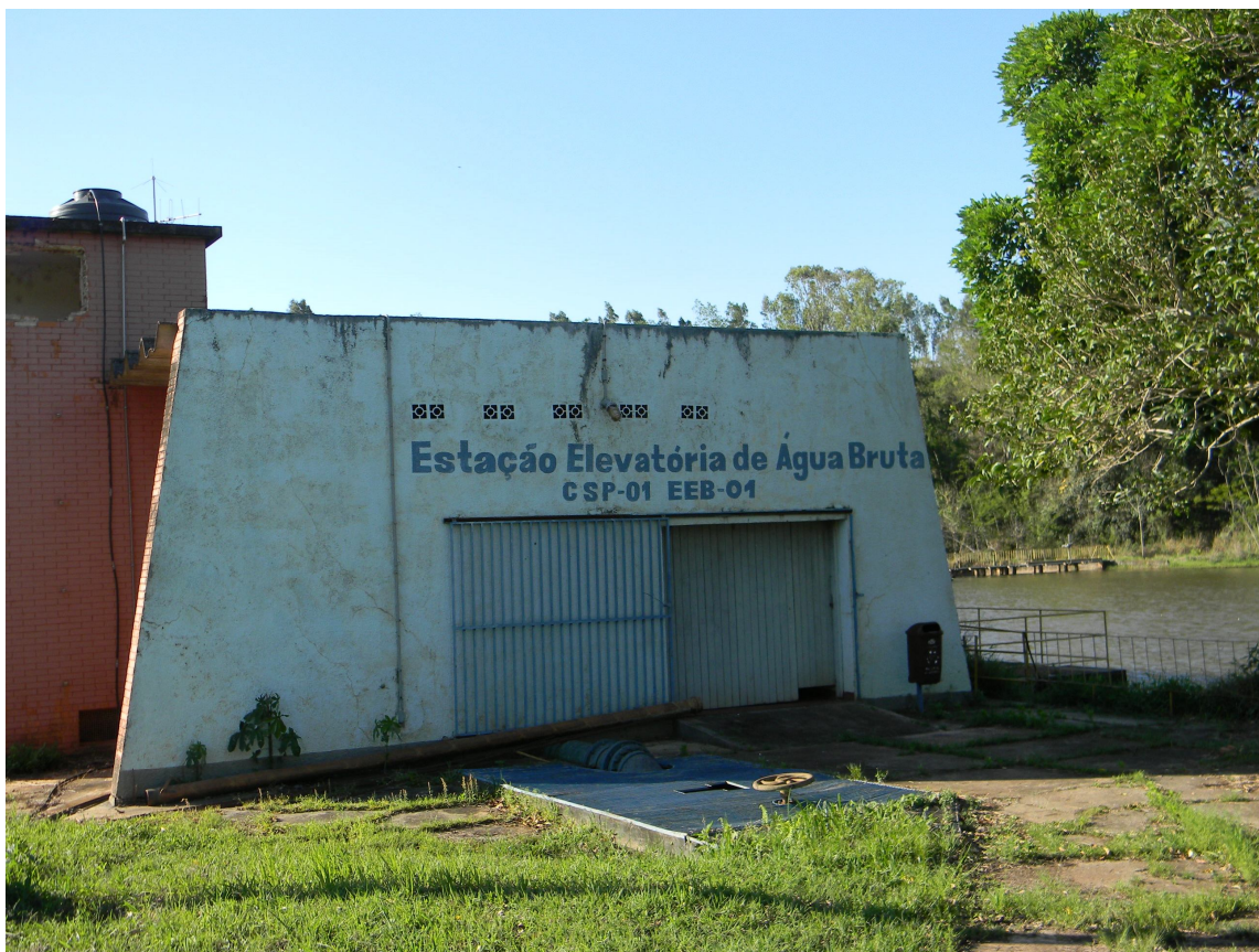
Figura 23. Estação Elevatória de Água Bruta
