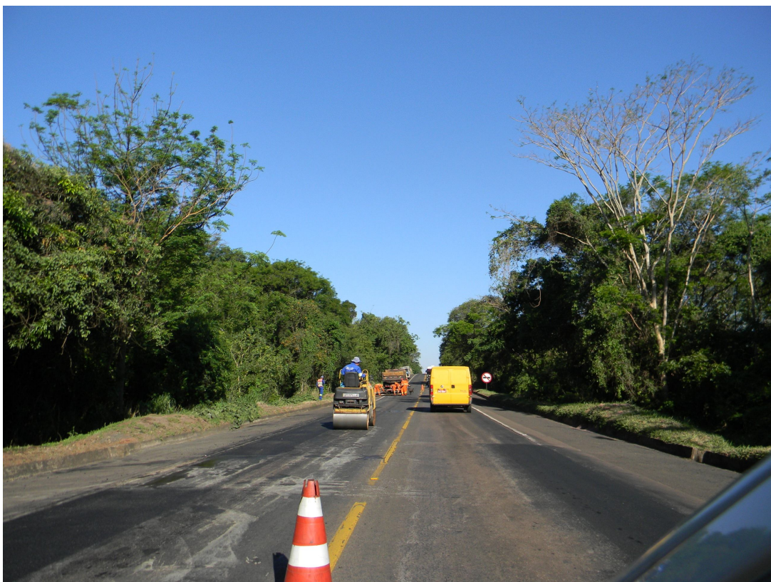
Figura 13. Operação de manutenção da rodovia BR 376
