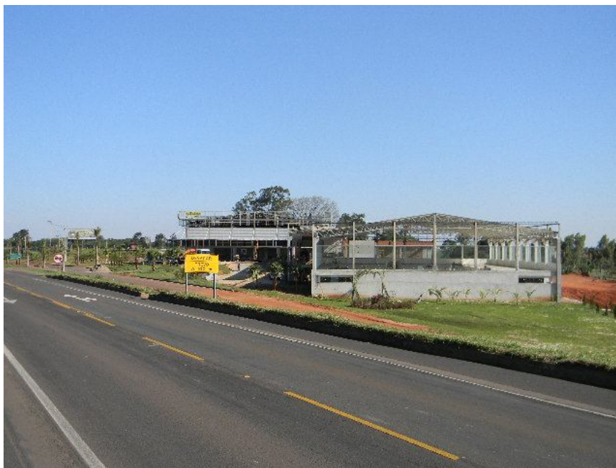
Figura 12. Foto de construção na área da APA
