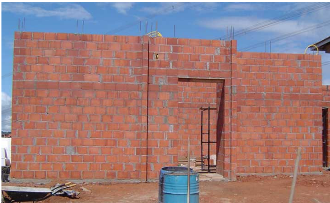
Figura 21: Construção em Alvenaria Estrutural Fonte: Fórum da Construção (2015).
