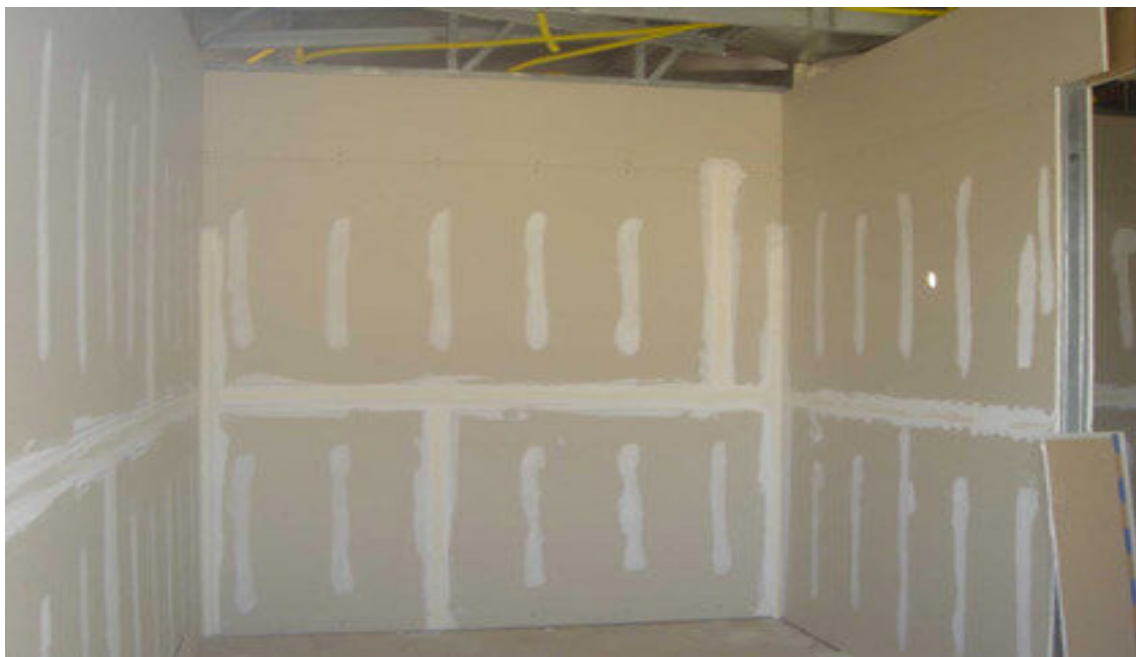
Figura 04: Revestimento interno em Placas de Gesso Fonte: Flasan (2015)
