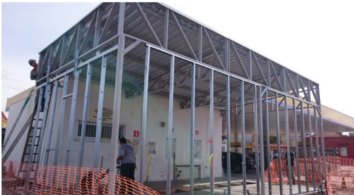
Figura 10: Montagem do Sistema de Steel Frame Perfis de Aço Fonte: O Autor (2015).
