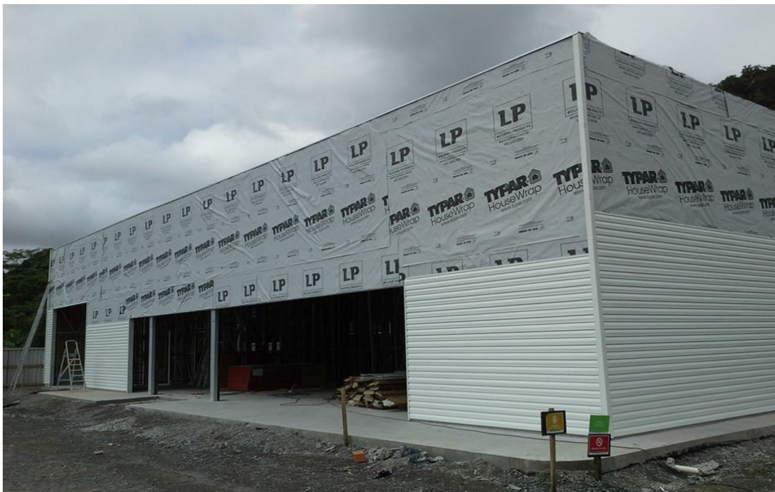
Figura 07: Revestimento Externo em PVC Fonte: O Autor (2015).
