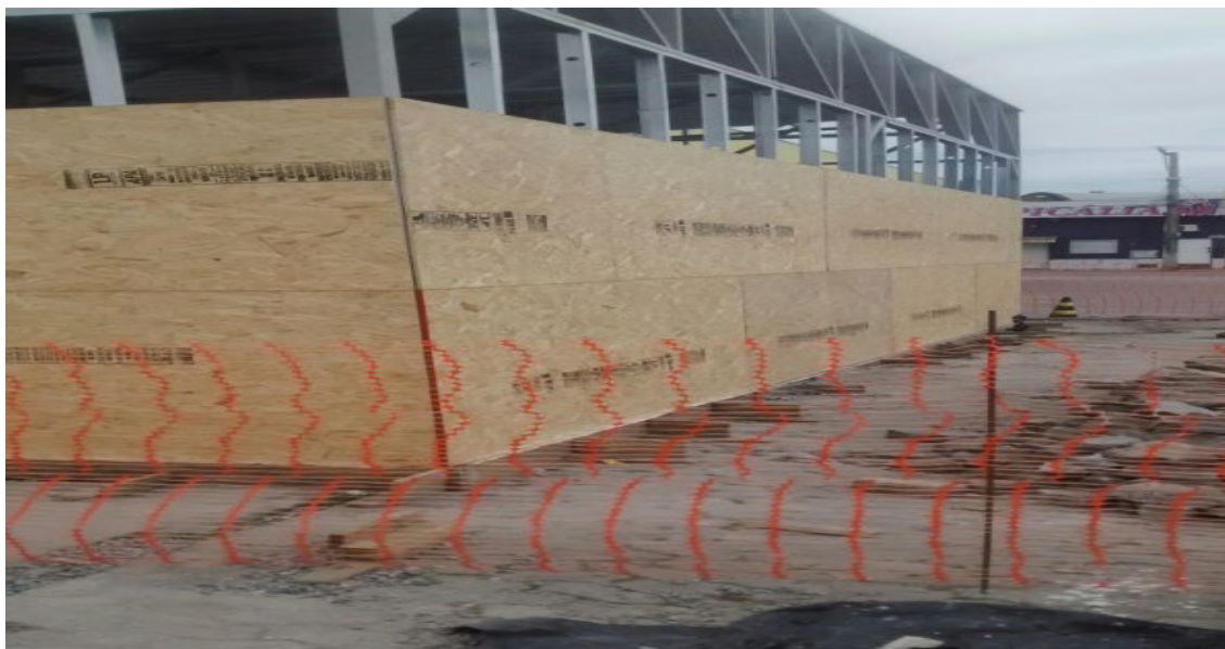
Figura 11: Início do Chapeamento com Placas de OSB Fonte: O Autor (2015).
