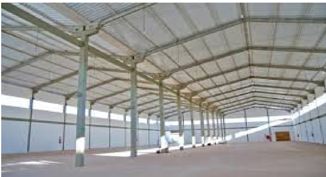
Figura 23: Pavilhão em Aço Fonte: Premol (2015).
