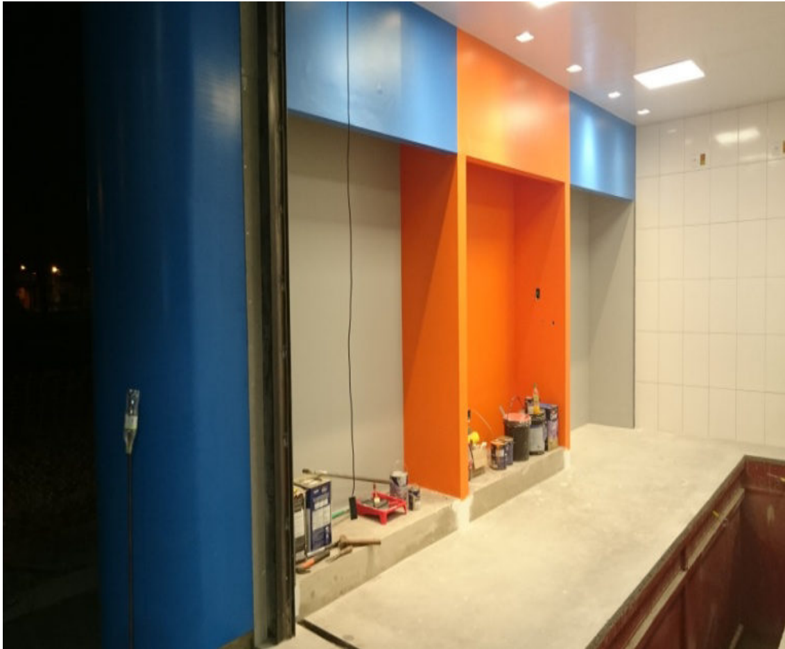
Figura 19: Tinta acrílica à base de água para acabamento interno. Fonte: Guia de Soluções ecoeficientes (2015), o autor (2015).
