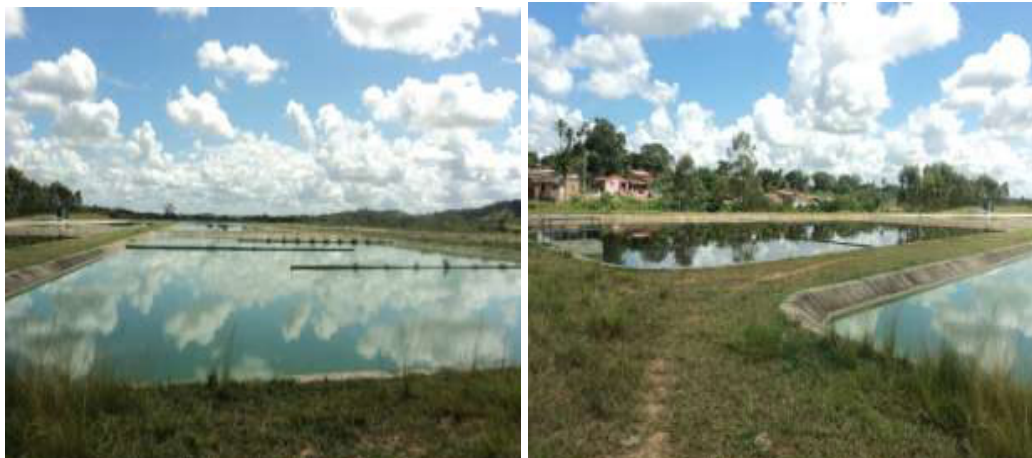
Figura 04: Vistas das Lagoas de Tratamento. Fonte: EMBASA (2014).
