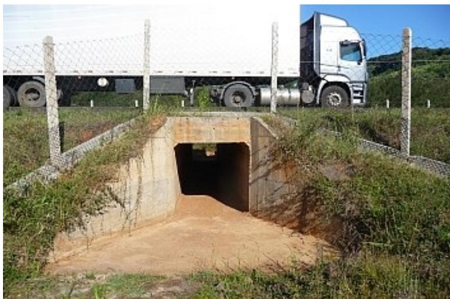
FIGURA 2: Passagem inferior de fauna (Fonte: Conecte).
