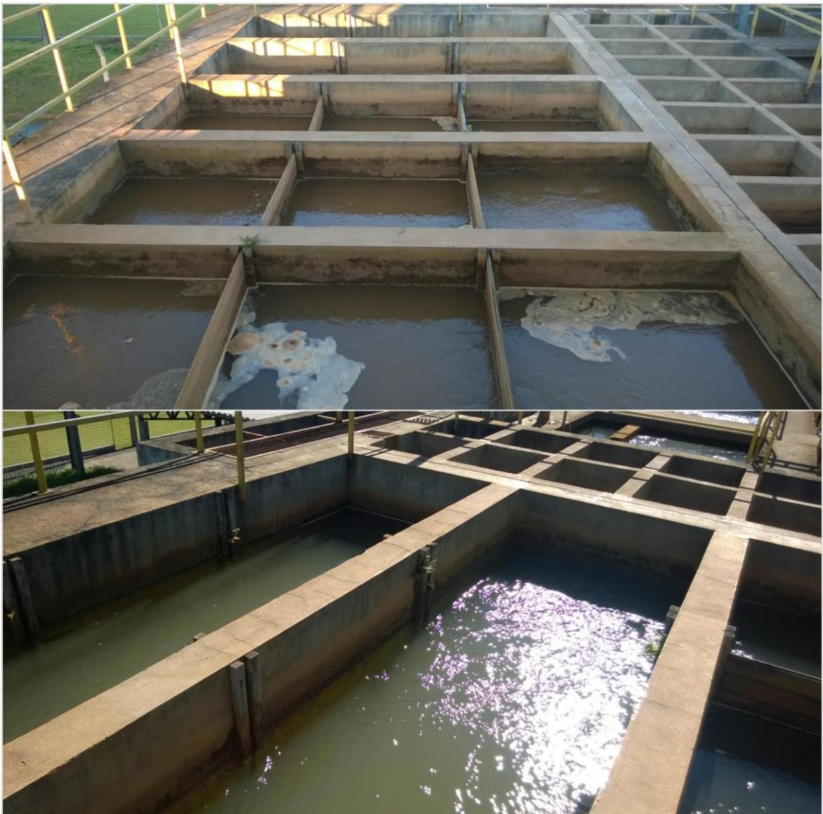
**Figura 6. Floculadores hidráulicos da ETA (imagens provenientes de períodos diferentes).**
