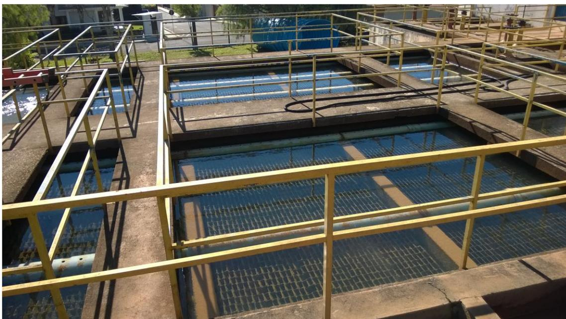
**Figura 9. Decantadores da ETA (após reforma).**
