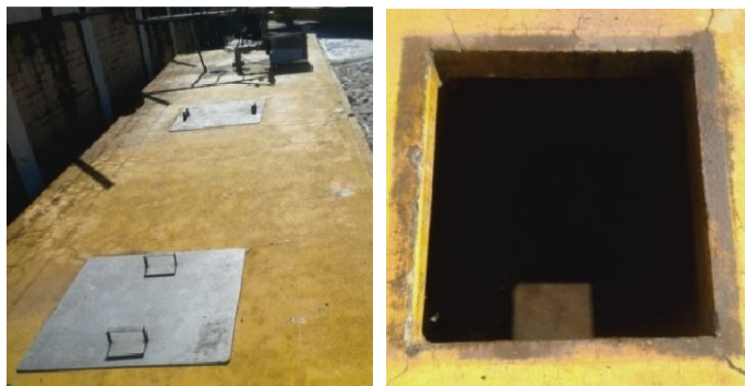
Figura 5. Caixa SAO onde foi realizada a coleta do efluente bruto da lavagem de ônibus
