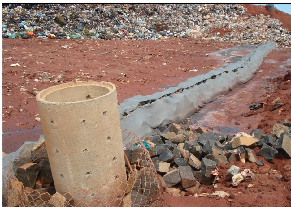
**Figura 4:** Drenos e Poços de Captação de Biogás.
