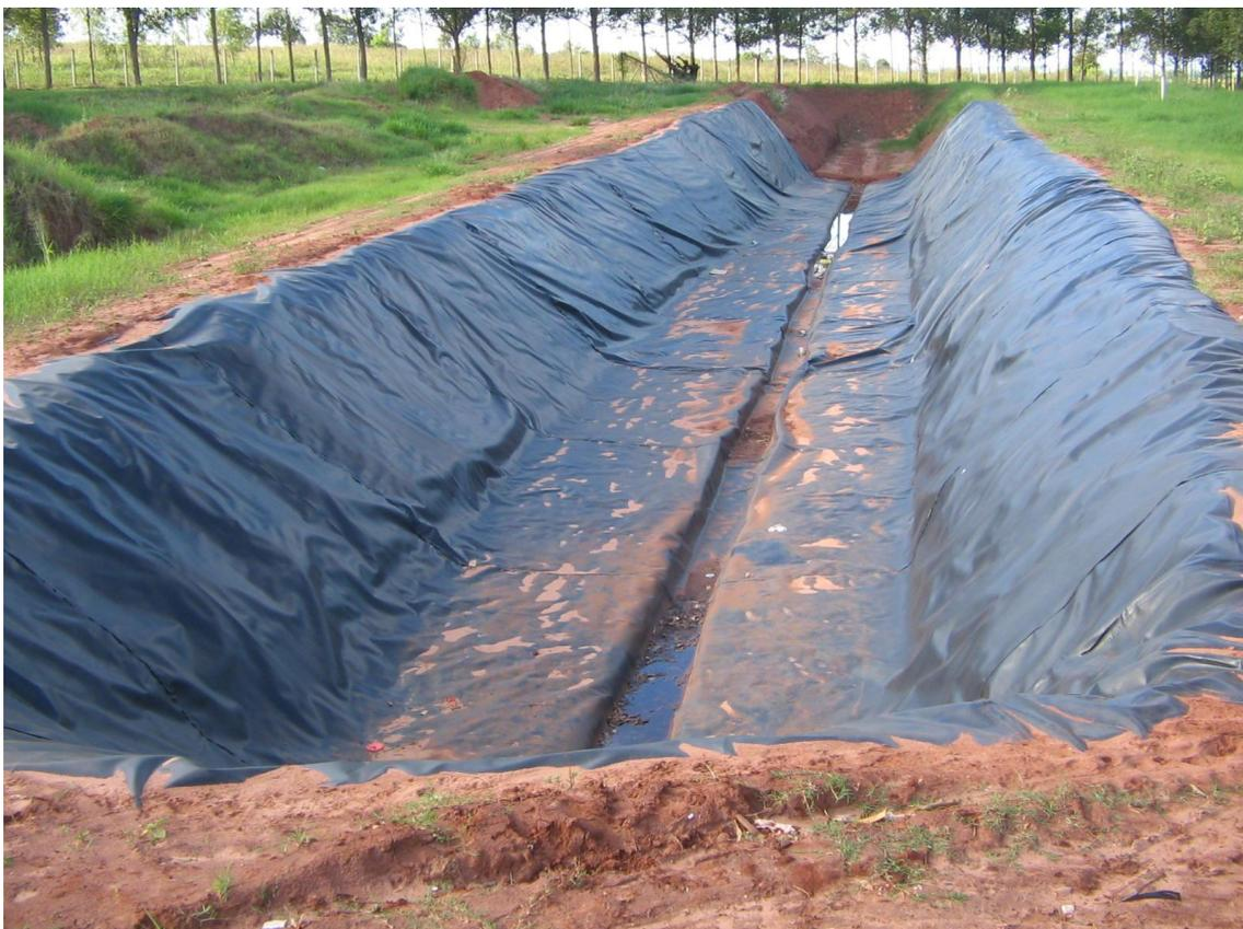
**Figura 04: Geomembrana no Aterro Sanitário**
