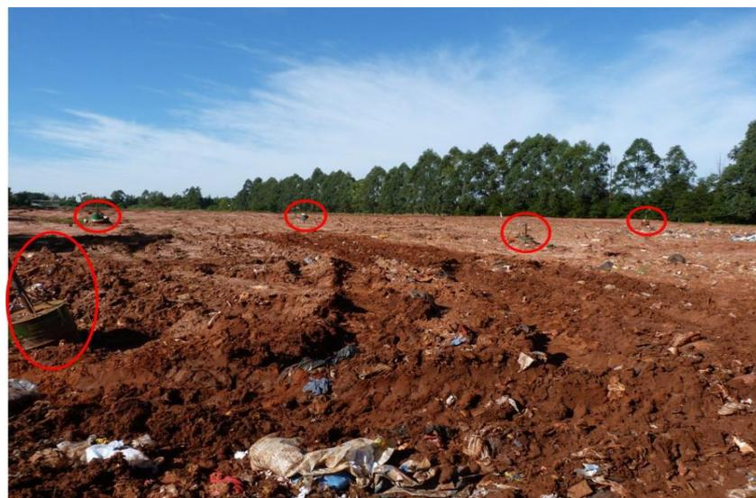
**Figura 12: Drenos e Queimadores de Gás do Aterro de Paranaíba.**
