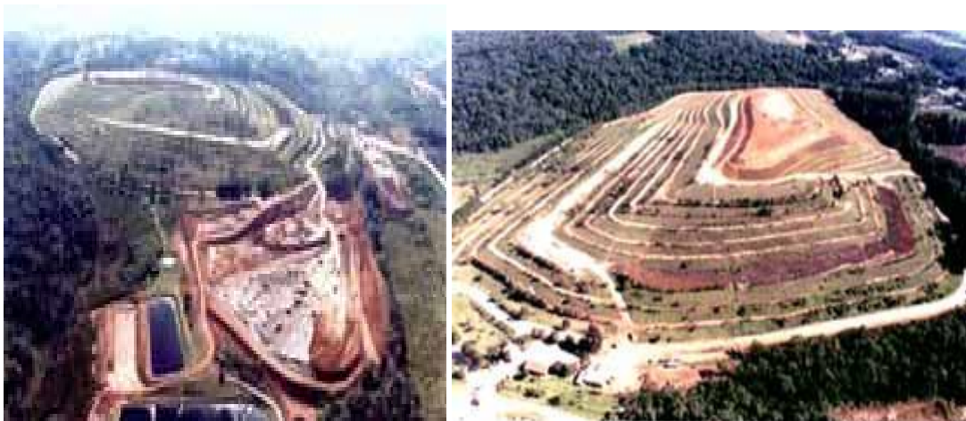
Figura 6: Aterro Sanitário da Caximba – Curitiba-PR Fonte: www.curitiba.pr.gov.br acesso em 09/03/2014
