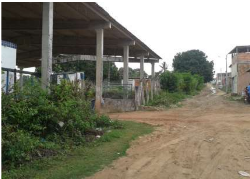
Figura 7- Imagem da rua paralela a Estação Sobocó onde apresenta fossas próximas ao poço 22. Fonte: Autor, 2018.
