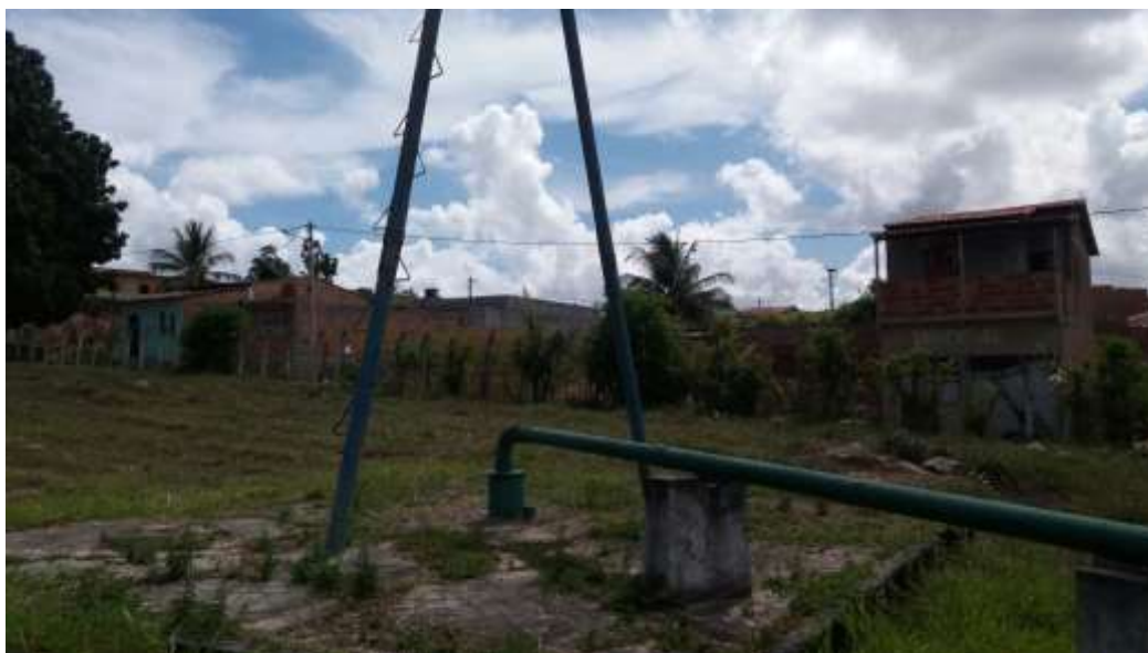
Figura 2- Poço 22 da Estação Sobocó. Fonte: Autor, 2018.
