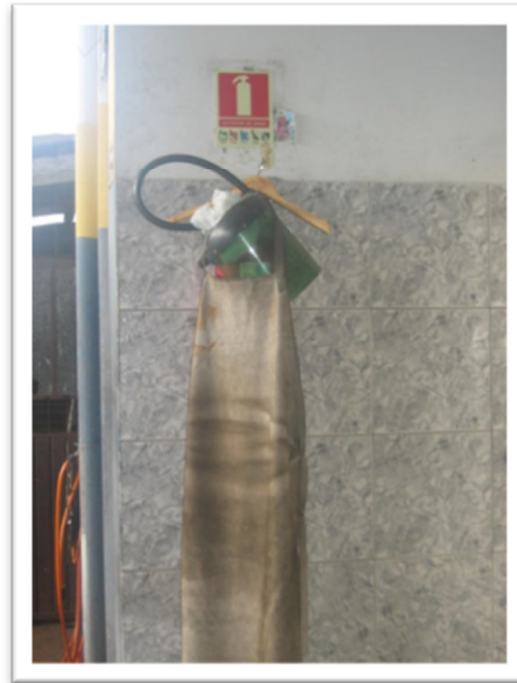
Figura 12 - Extintor encoberto pelo EPI Fonte: BEUX, Giovana. Arquivo pessoal (2013)
