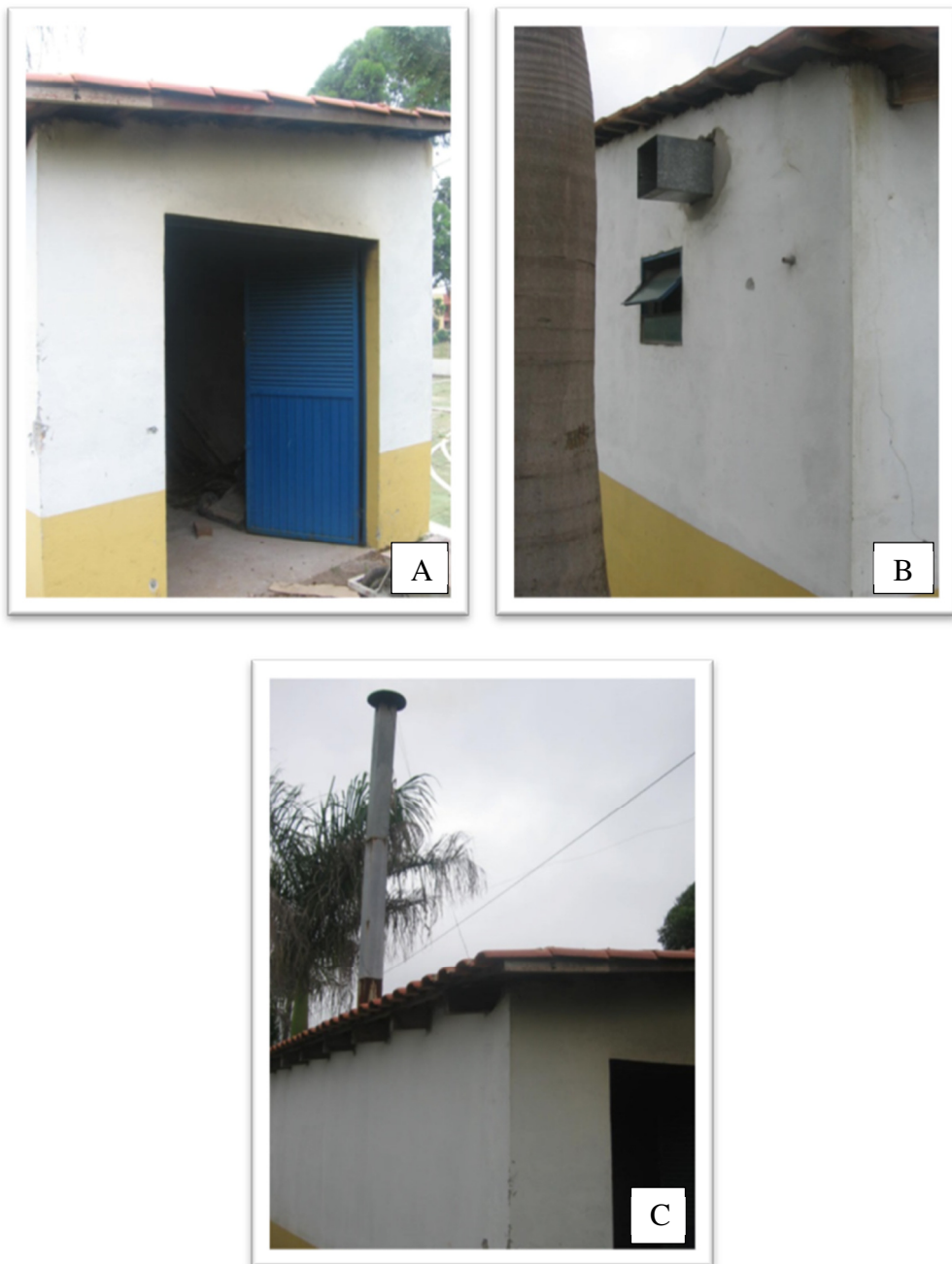
Figura 15 - Casa da caldeira 5 (A), Saída casa da caldeira (B) e chaminé (C) Fonte: BEUX, G. Arquivo pessoal (2013)
