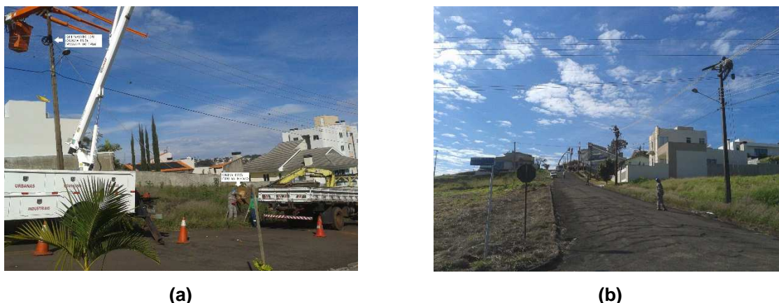
Figura 17 – Recolhimento do Cabo de Média Tensão: (a) Estrutura para o recolhimento; (b) Postes envolvidos.
