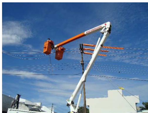
Figura 8 – Atividade de alteração de estrutura de MT do poste.
