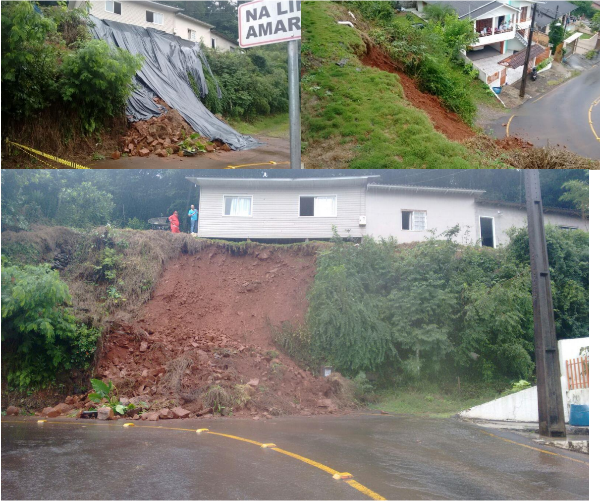
Figura 22 – Deslizamento ocorrido no dia 18 de dezembro de 2015, no Bairro Nossa Senhora Aparecida.
