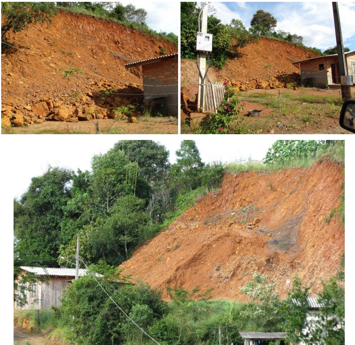
Figura 20 – Situação encontrada após o deslizamento ocorrido em 30 de novembro de 2015, no Bairro São Cristóvão.
