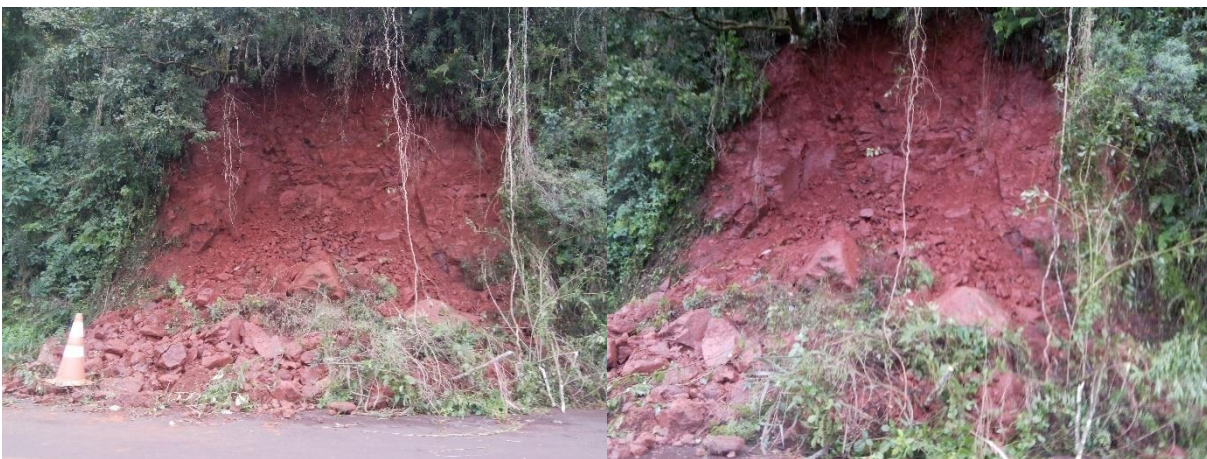
Figura 23 – Deslizamento ocorrido no dia 20 de maio de 2016, na Linha Santa Bárbara.
