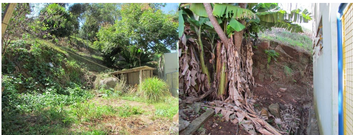
Figura 25–Vestígio de queda de blocos encontrada no bairro Cristo Rei na cidade de Francisco Beltrão.
