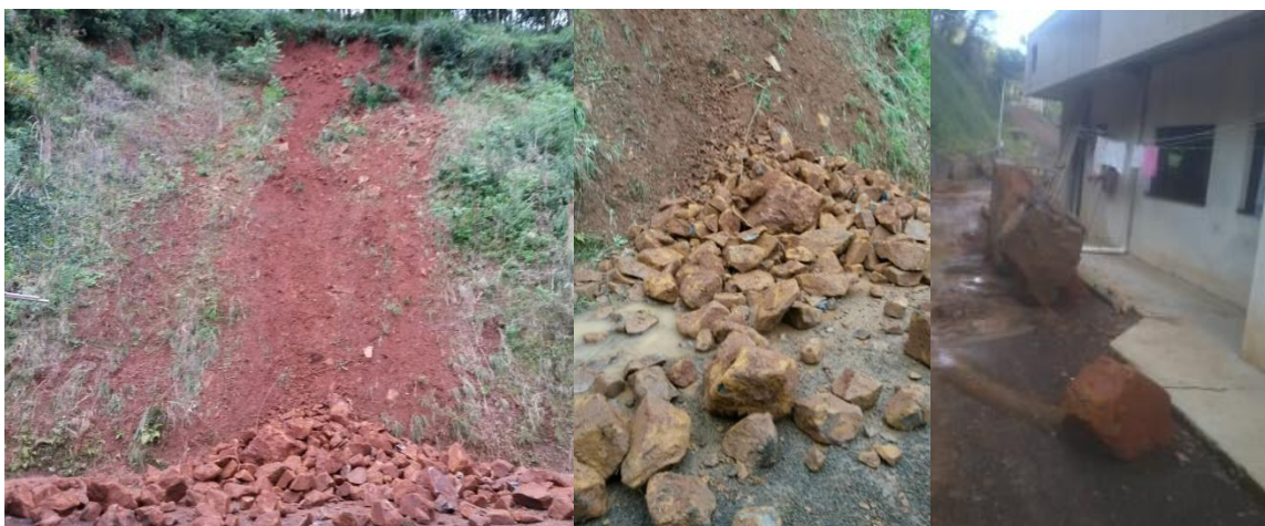
Figura 24 – Deslizamento ocorrido no dia 30 de maio de 2016, no bairro Jardim Seminário. Fonte: Defesa Civil de Francisco Beltrão.
