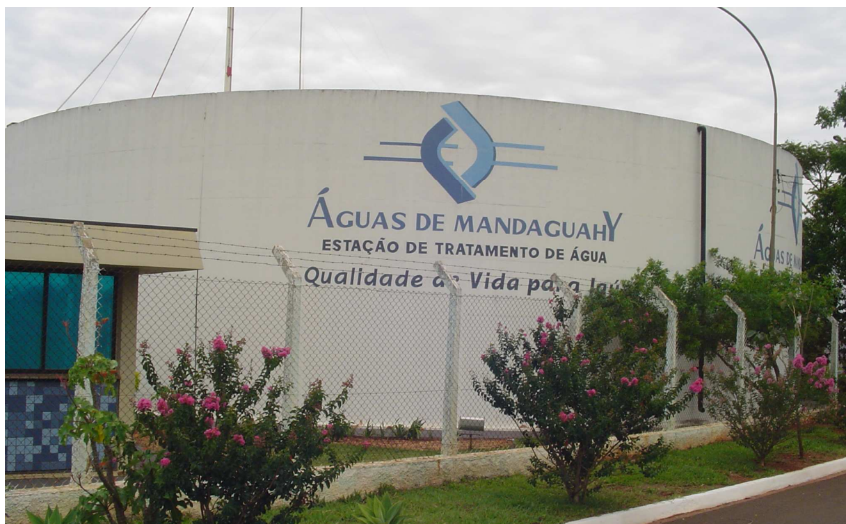
Estação de tratamento ETA II – Jaú Fonte: PUTTI, L.D.; out. 2010.
