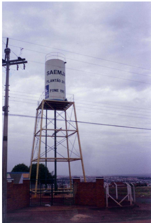
Fig (7) – Reservatórios Vila Industrial Fonte: Arquivo Saemja. nov. 2010.
