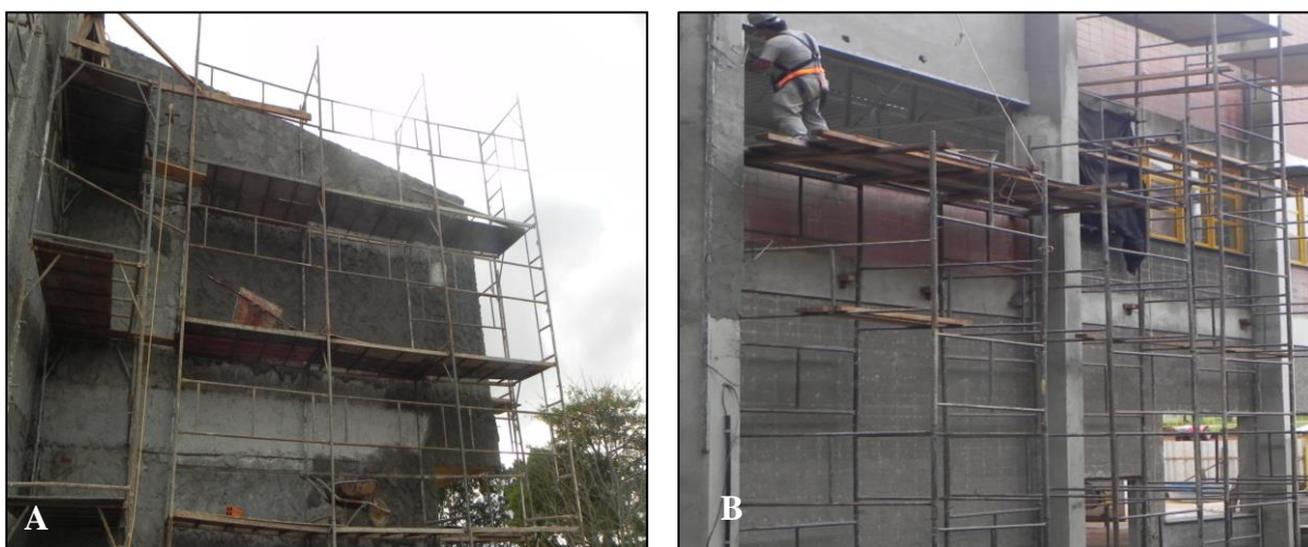
Figura 66 - Utilização de andaimes no canteiro de obras. A) Vista do andaime tipo fachadeiro; B) Trabalhadores utilizando os andaimes.
