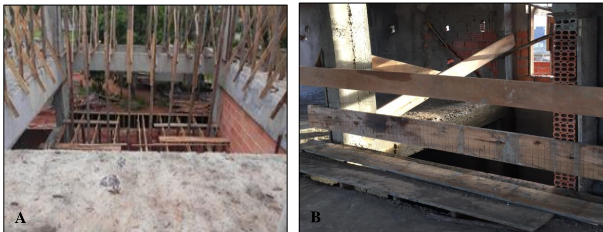
Figura 60 - Verificação das medidas de proteção em vãos de escadas e elevador. A) Vão da escada, na laje, antes da sua execução, sem proteção contra quedas; B) Proteção contra queda de altura.
