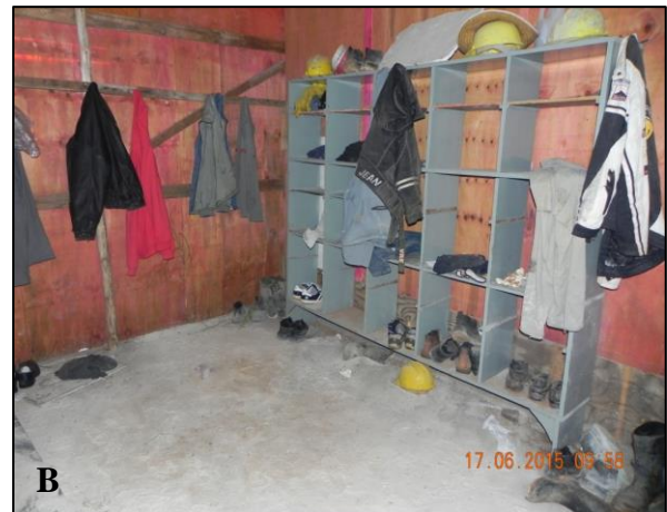
Figura 13 - Não conformidades encontradas no vestiário. A) Armários não são dotados de fechadura; B) Pisos em concreto do vestiário executado nove meses após o início da obra. Fonte: a autora (2016).
