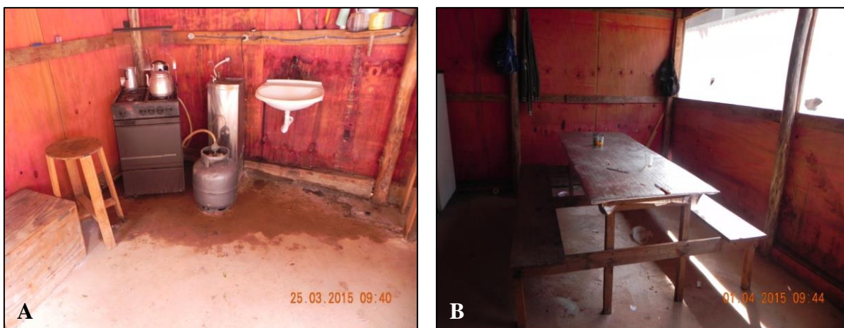
Figura 14 - Não conformidades encontradas no local de refeição. A) O botijão de GLP encontra-se dentro do local de refeições; B) O local de refeição não possui capacidade para atender todos os trabalhadores. Fonte: a autora (2016).
