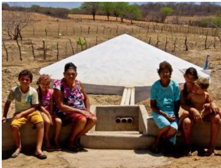
Figura 12. Cisterna tipo enxurrada - retirada da água por uma bomba manual.
