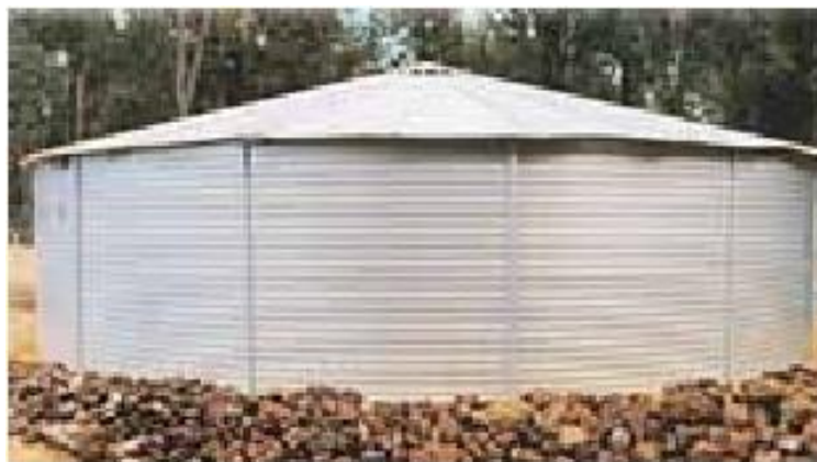
Figura 13. Grande tanque metálico em área rural da Austrália.
