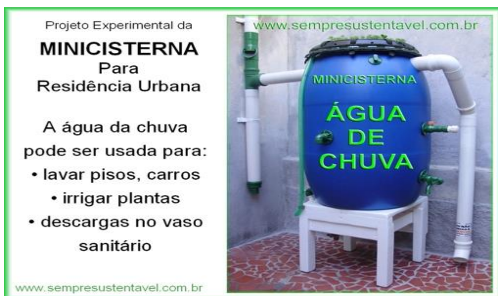
Figura 17. Fotografia de uma minicisterna Barris utilizados para o armazenamento de água de chuva. Fonte: www.sempresustentavel.com.br
