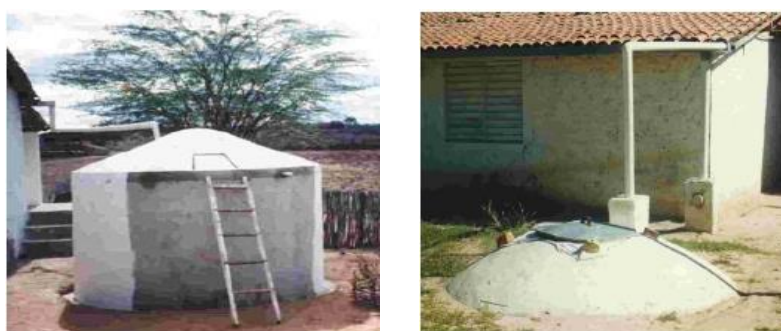
Figura 11. Cisterna sobre a superfície e cisterna enterrada.
