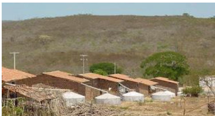
Figura 10. Cisterna de placas em assentamento.
