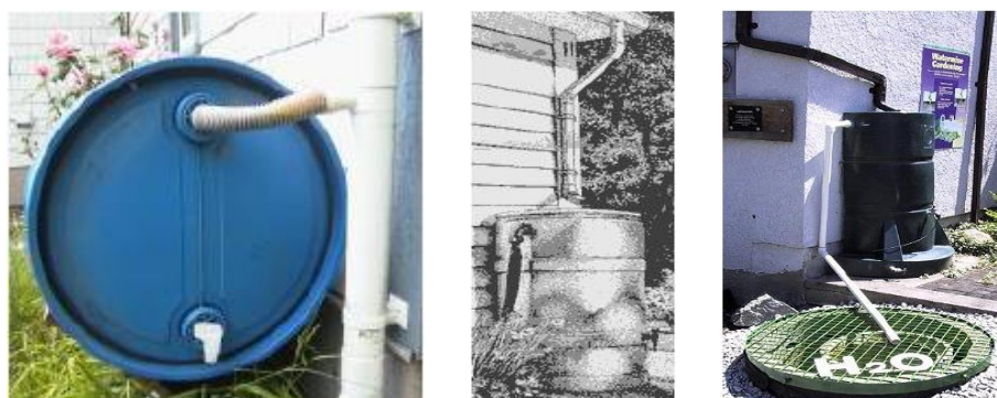
Figura 16. Barris utilizados para o armazenamento de água de chuva.
