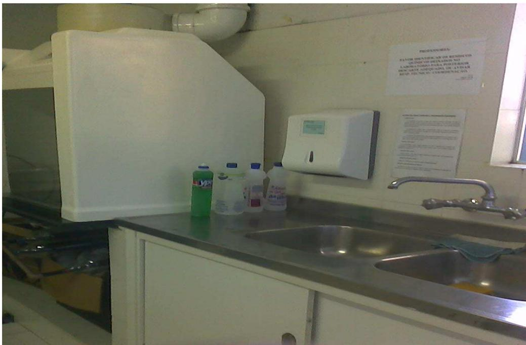
*Figura 05: Pia e capela instaladas perto da janela e do exaustor que já existiam na sala cedida para a montagem do laboratório.*
