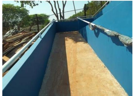
**Figura 18 - Rampa em construção com corrimão muito alto.**
