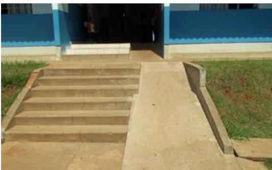
**Figura 19 – Acesso à escola com escadas e rampa sem corrimão e com piso irregular**
