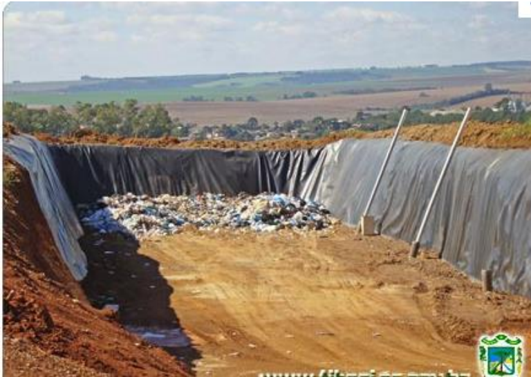
Figura 11 - Aterro sanitário com trincheira impermeabilizada Fonte:SEMA, Tibagi/2012
