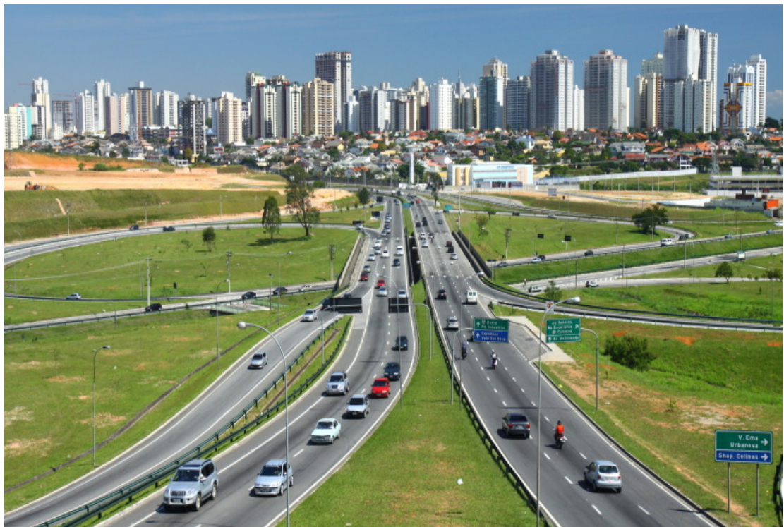
Figura 6 – Vista do Anel viário – Avenida Florestan Fernandes. Fonte: Prefeitura Municipal de São José dos Campos – SP (2011).
