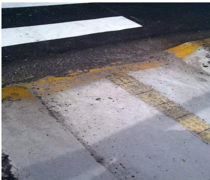
Figura 11 - Instalação errada do piso tátil, no sentido contrário da faixa de pedestre.
