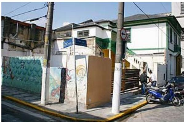
Figura 9 - Esquinas das Ruas Pe. João e Flaviano de Melo, no centro de Mogi das Cruzes, percebe-se barreiras na calçada, falta de guia rebaixada e piso tátil.
