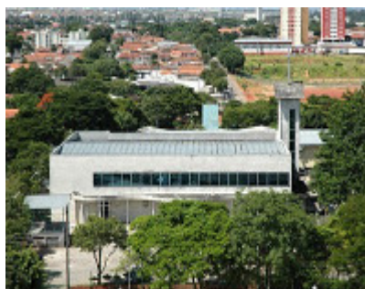
Figura6- Paróquia Nossa Senhora de Lourdes. Fonte: Site da Diocese de São José dos Campos, 2011.
