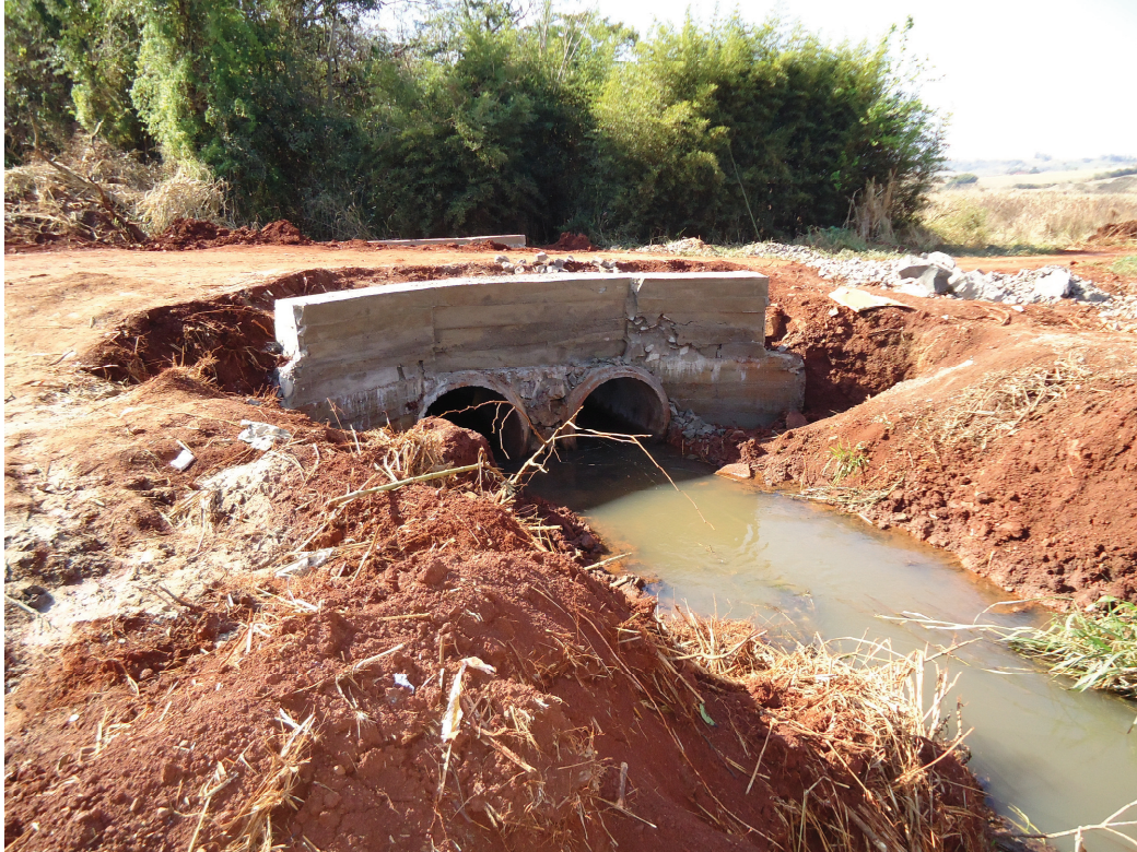
Imagem 4: Ponte sobre o Ribeirão Água do Arara
