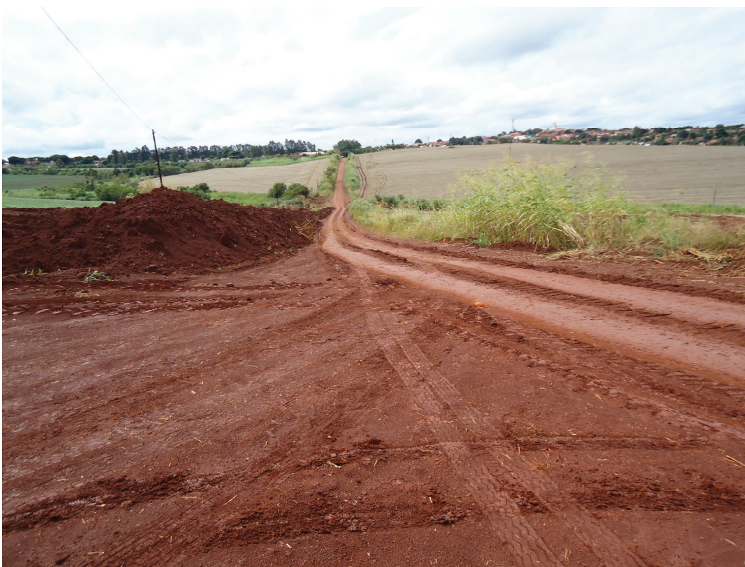
Imagem 3: Estradas dos carreadores sendo refeitas
