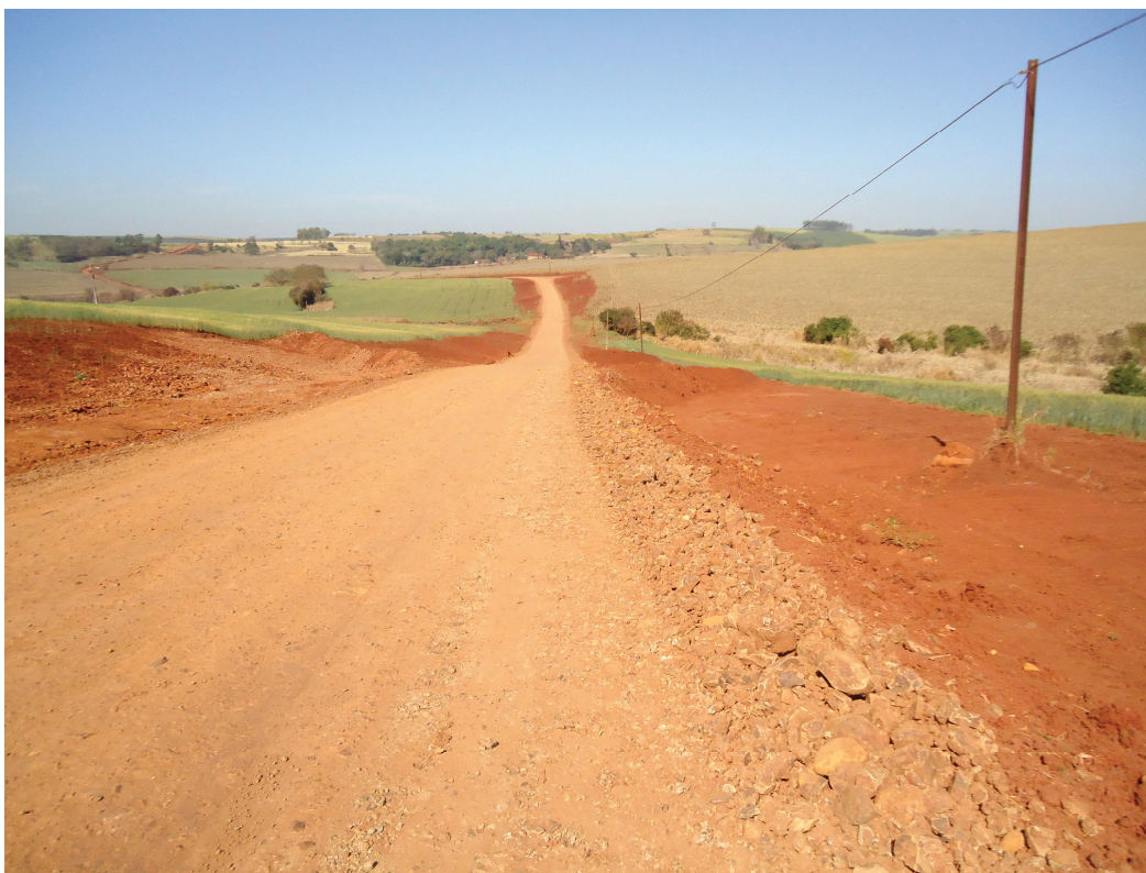
Imagem 1: Estrada vicinal cascalhada e com terraço de retenção de água.
