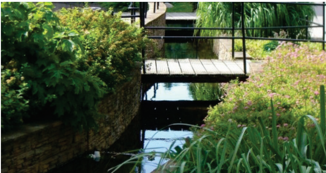
Figura 17 – Canal para escoamento de água pluvial em Augustenborg (Malmö) - Suécia Fonte: http://www.satya.com/malmo/attractions/19339/augustenborg/ (Acesso em: 04 nov 2011)
