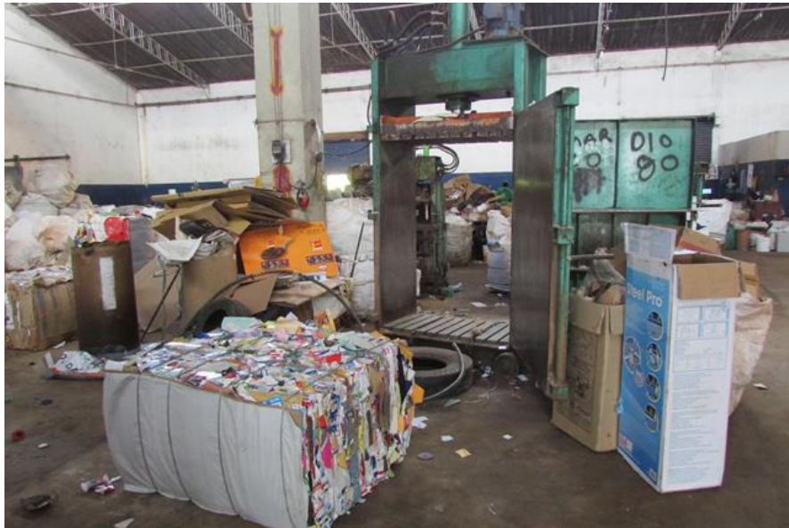
Figura 15 – Prensa para compactação dos materiais já separados
