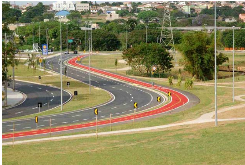
Figura 18 - Ciclovia lateral na rodovia SP-79, entre as cidades de Itu e Sorocaba-SP. Fonte: < http://www.webbikers.com.br/blog/?p=1815 > Acesso em 14 set. 2014.
