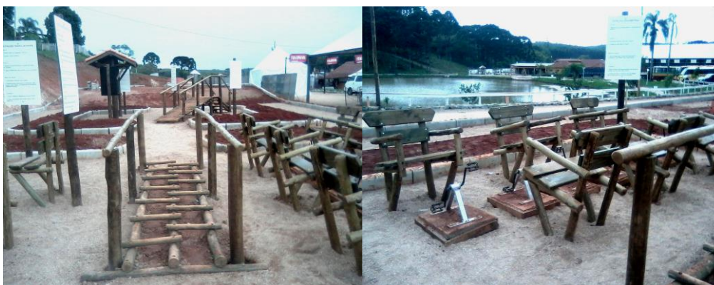
Fotografia 8: Construção da Praça do Idoso Fonte: Arquivo próprio (2012)
