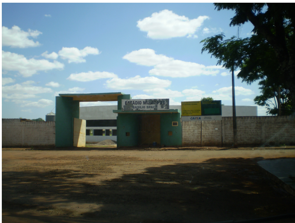
FIGURA 12: Centro de Eventos do município de Juranda – em construção Fonte: elaboração da autora.
