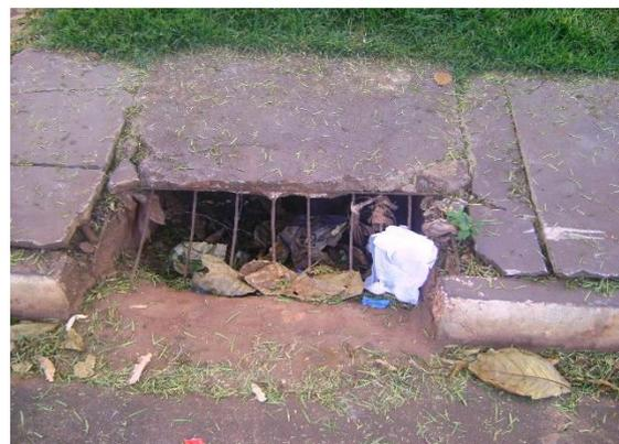
**Figura 3** - Galeria pluvial entupida por sedimentos, folhas e lixo inorgânico, Vila Malvinas - Guaíra-Pr.
