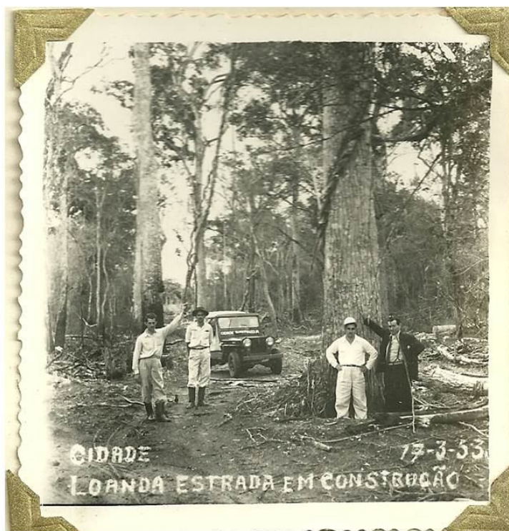
Figura 11: Estrada em construção em 17 de março de 1953. Ao centro Ásio Monticuco Fonte: Acervo Sebastião Delfino Machado
