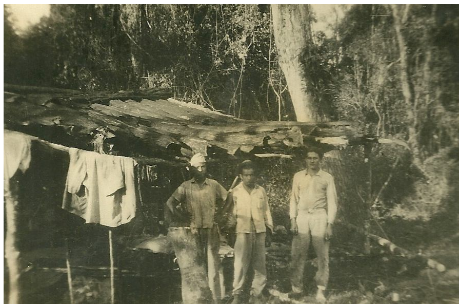
Figura 15: trabalhadores abrindo estrada. Loanda 11 de marco de 1953
