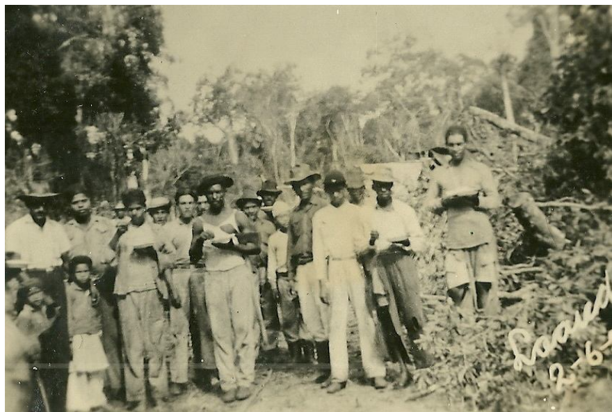
Figura 16: Trabalhadores almoçando. 02 de junho de 1952. Fonte: Acervo Sebastião Delfino Machado
