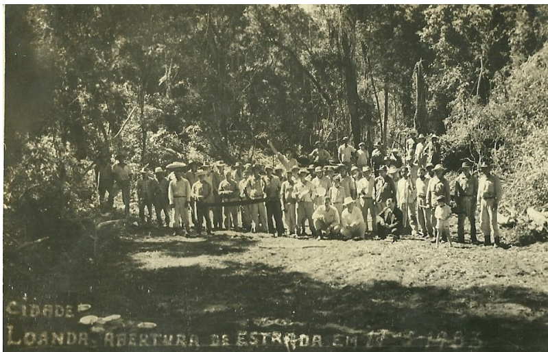
Figura 14: trabalhadores abrindo estrada. Loanda 11 de marco de 1953
