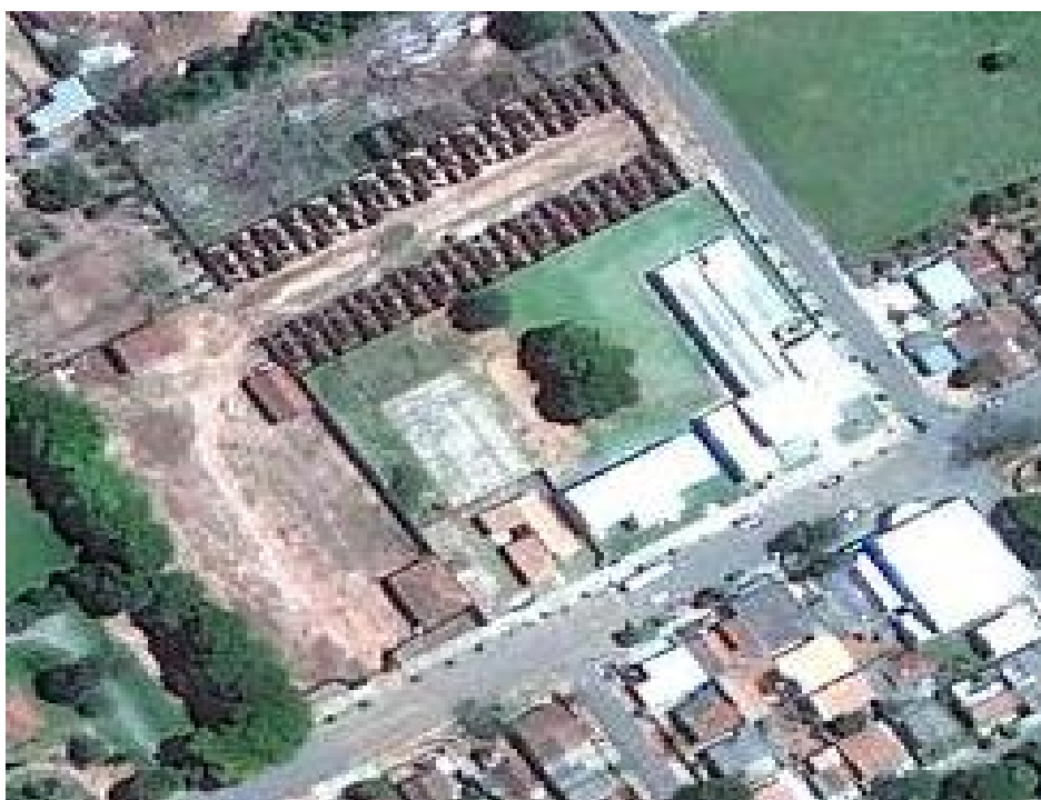
Figura 2 – Localização Aérea da Escola Municipal Júlio Benatti –Ensino Fundamental. Fonte: Google Earth (2012).
